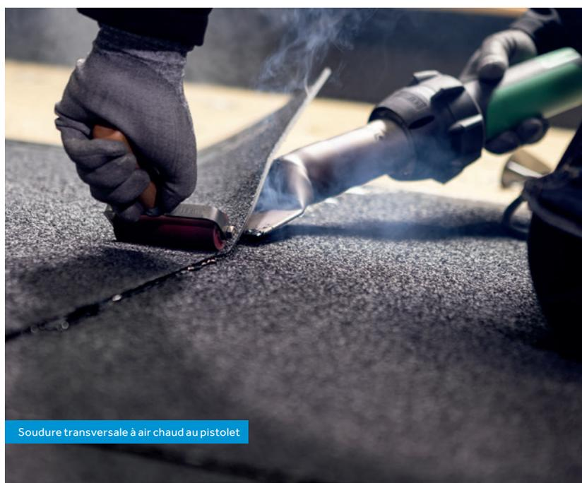
Soudure transversale à air chaud au pistolet
